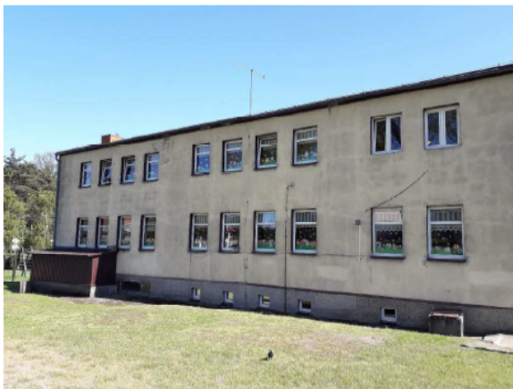
Zdj. 2. Elewacja północna
