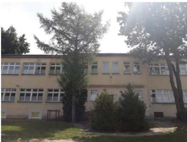
Zdj. 2. Elewacja zachodnia
