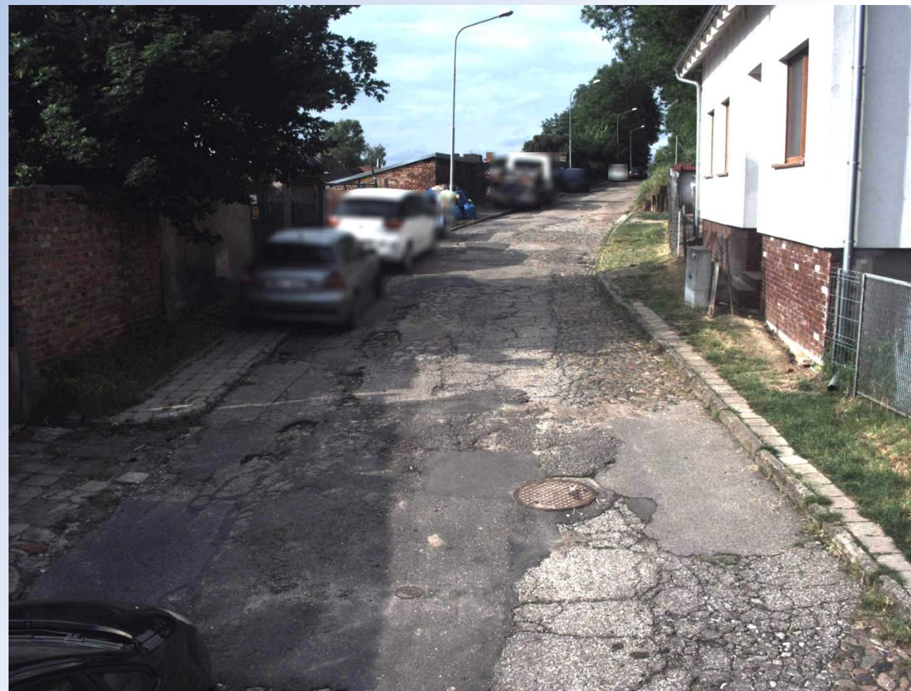
Ul. Podgórna – stan istniejący
