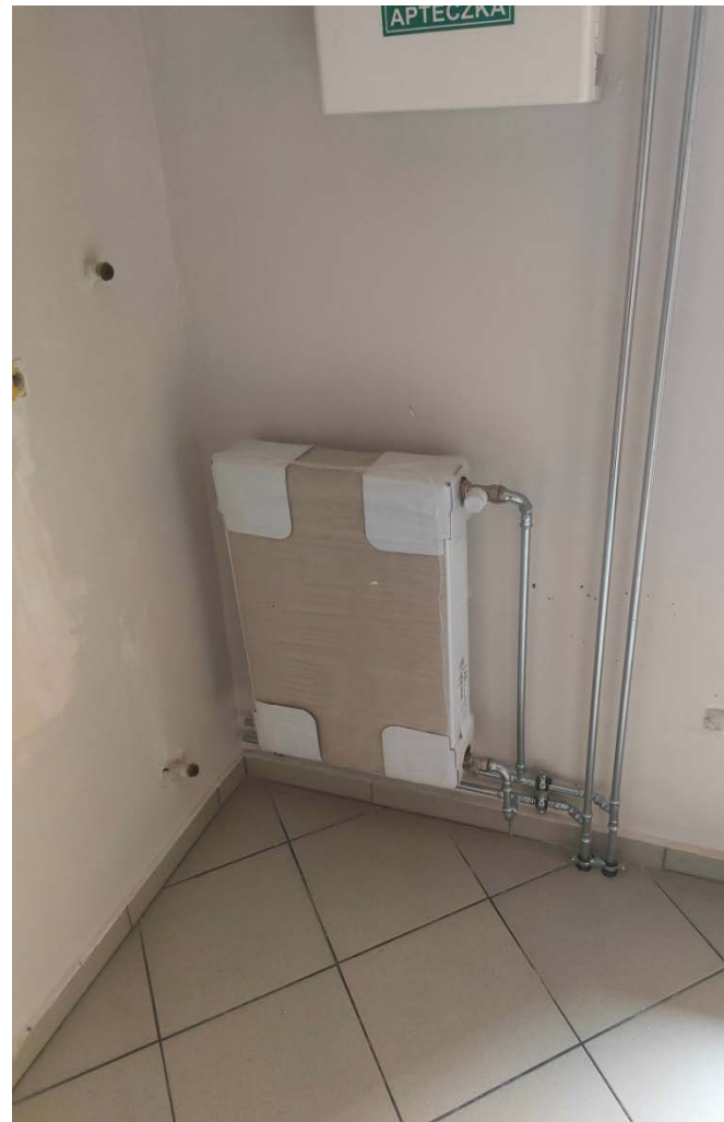
Wymiana instalacji c.o.
