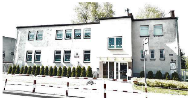
Zdj. 1. Elewacja południowa (frontowa)
