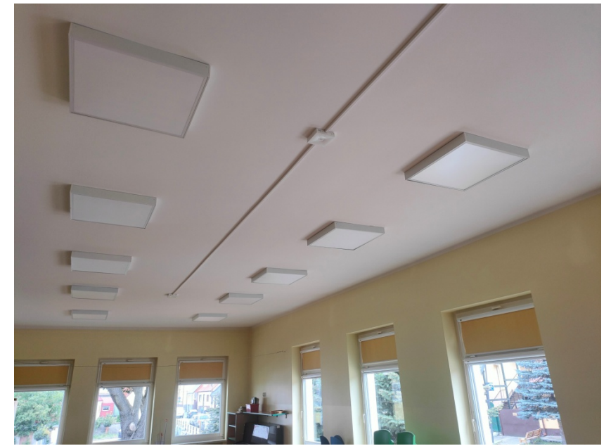
Wymiana opraw oświetleniowych
