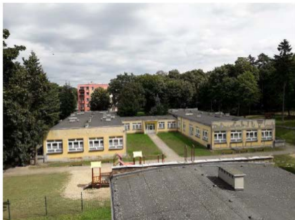
Zdj. 4. Elewacja zachodnia
