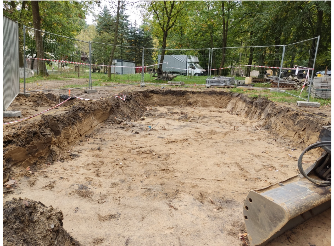
Budowa nowej fontanny
